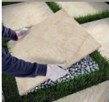
Pokládka na trávne plochy
