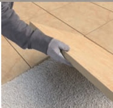
Pokládka na štrk
