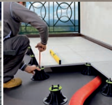
Pokládka na terče
